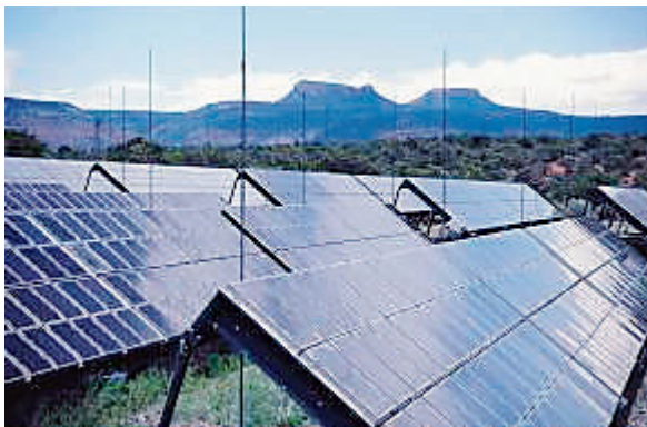
ソーラーパネル（太陽電池）設置風景
