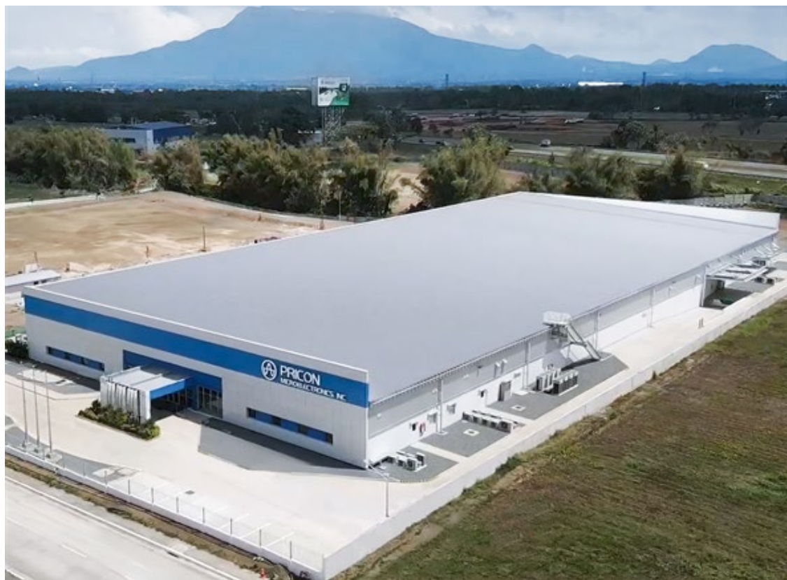
Pricon Microelectronics, Inc. 第3工場 屋根上に太陽光パネルを設置中
